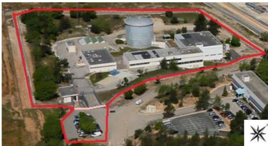
Figure 3 – Vue aérienne de l'installation Masurca et de son périmètre (Source : dossier)
